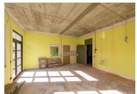
Die Sanierung der HPT soll im Februar 2018 abgeschlossen sein. © KJF/ Klaus D. Wolf
