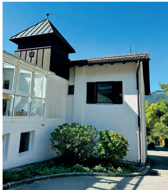
Die beiden Gebäudetrakte der Wohngruppen und der Verwaltung sind durch einen Gang miteinander verbunden.
