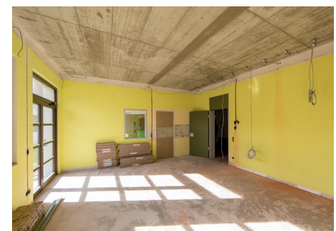
Die Sanierung der HPT soll im Februar 2018 abgeschlossen sein. © KJF/ Klaus D. Wolf
